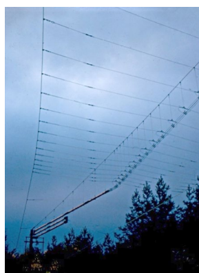
Riktantenn 4 – 30 MHz 10 kW
