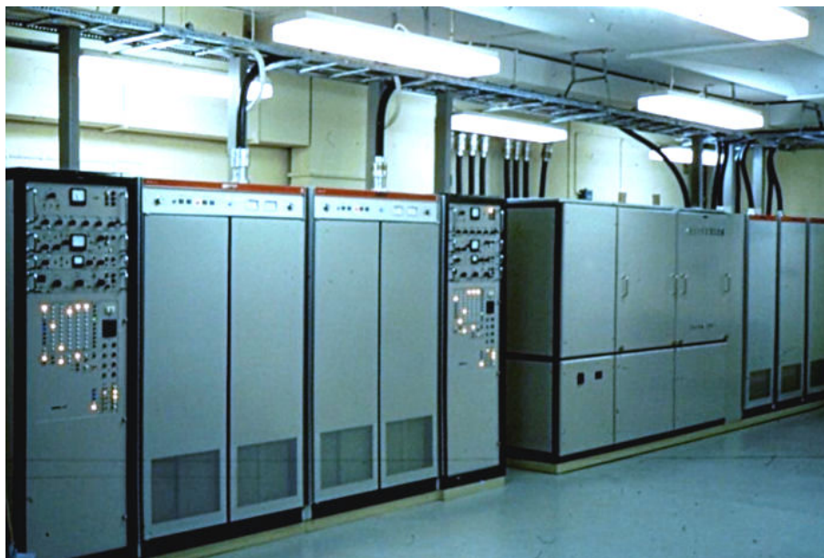
Radiosändare FMR 14 i fred's Hs sändarbunker
