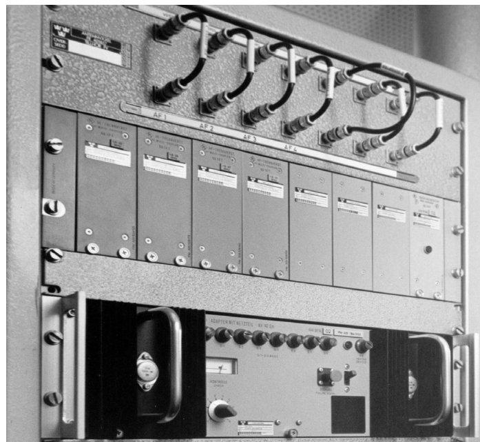
Antennförstärkare NV14 med Antennförväxel
