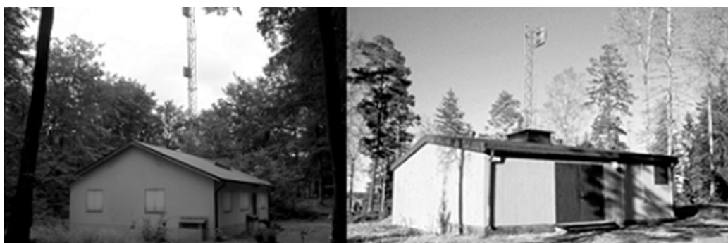
Us Mottagaranläggning och Us Sändarannex
