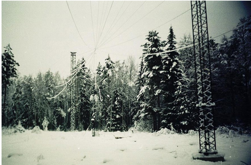
Scheuerecker dipolantenn 2 – 9 MHz 10 kW
