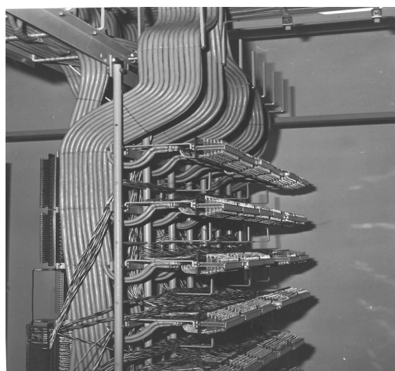
Mellan-omkopplingsstativ med kablage
