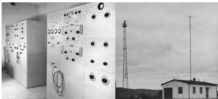
Fast Markradio typ 1, LV- & KV-Sändare, Stationshus med KV-antenn & LV-antenn
